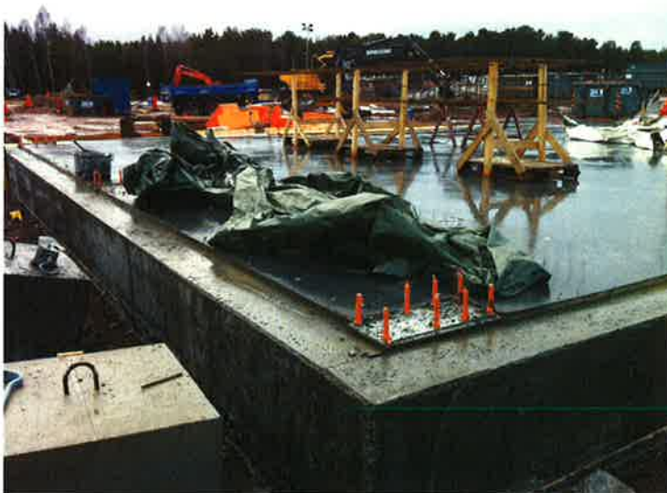
Figur 1. Bottenplatta i byggnadens nordvästra hörn.
