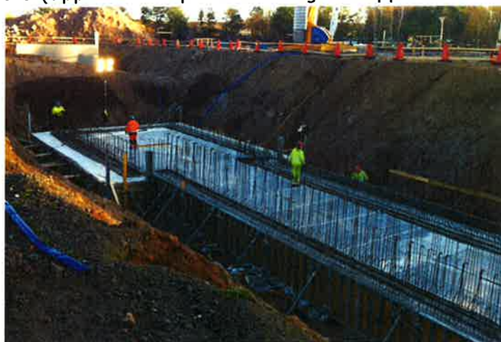
Figur 1. Gjuten bottenplatta i tippficka för optisk sortering
