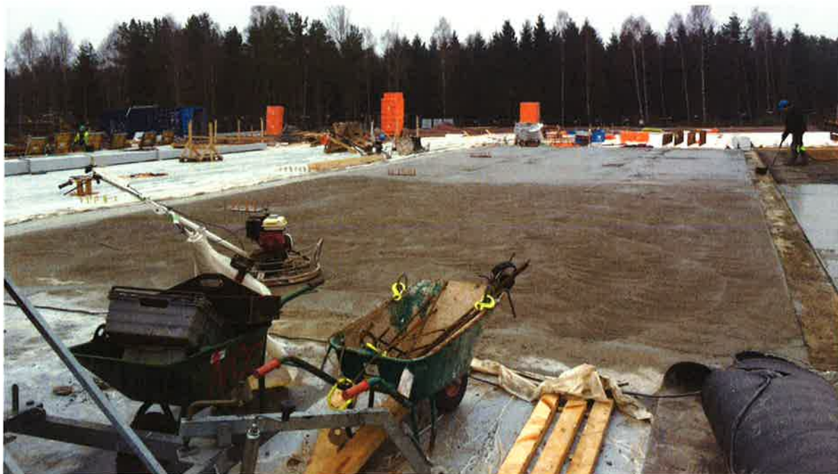
Arbetsytan i samband med gjutarbete 140227
