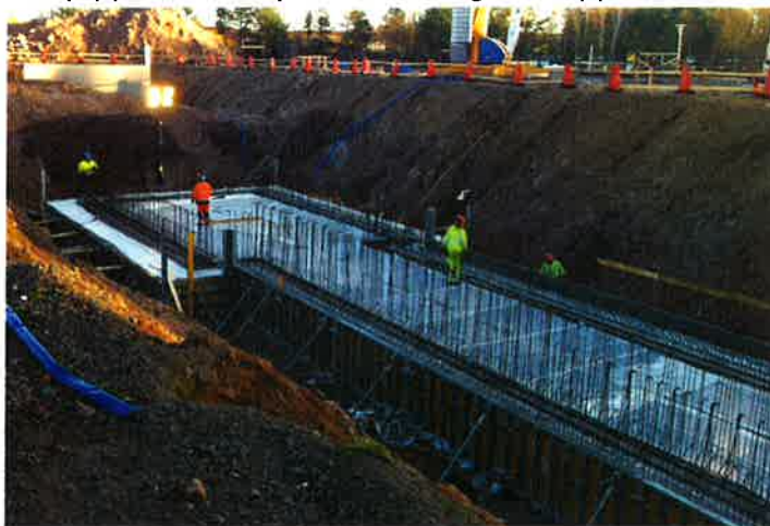
Figur 1. Gjuten bottenplatta i tippficka för optisk sortering
